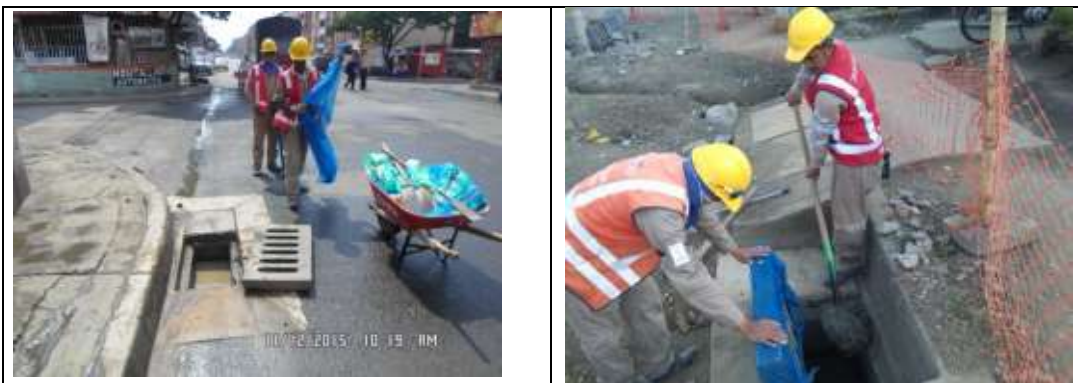
Mantenimiento de sumideros.
